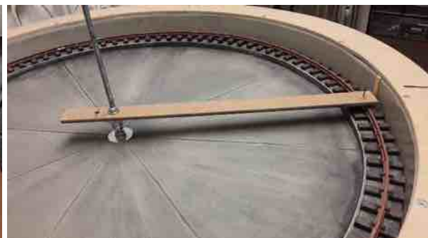
DE RONDRAIL WORDT UITGELIJD
