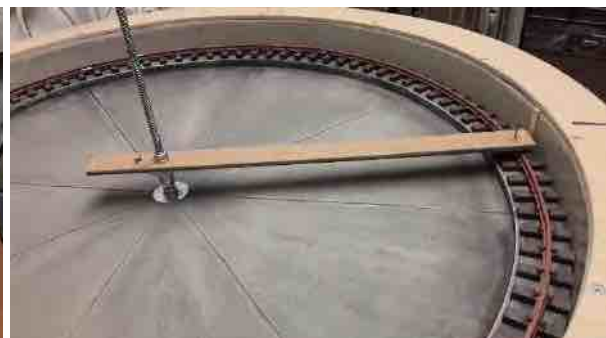
DE RONDRAIL WORDT UITGELIJD
